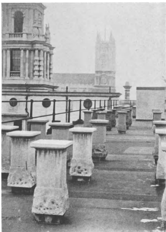
Abb. 2. Probekörper in Form von großen Pfeilern. (Nach Building Research Board, Report for 1926.)
