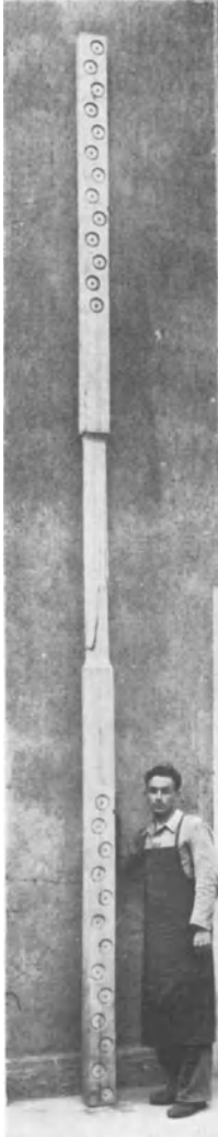
Abb. 24. Zugstab mit 60 cm 2 kleinstem Querschnitt (Gesamtlänge 5,6 m, Länge der Einspannköpfe je 2,2 m). (Nach GRAF und EGNER.)
