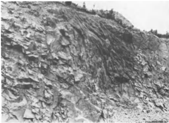
Abb. 2. Stark zerklüfteter Granit. Schotterrohgut.
