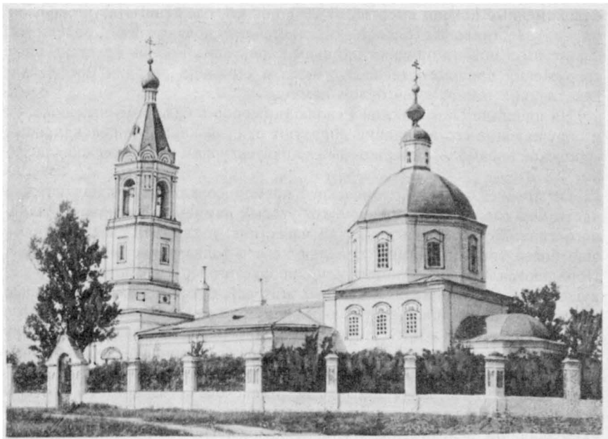
Рис. 19. Кирпичная, побеленная под белый камень Воздвиженская церковь в с. Марçуги, построенная в стиле московского барокко (1768 г.)
