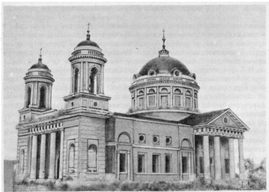
Рис. 23. Духовская церковь с ротондой и двумя колокольнями в с. Шкинъ
