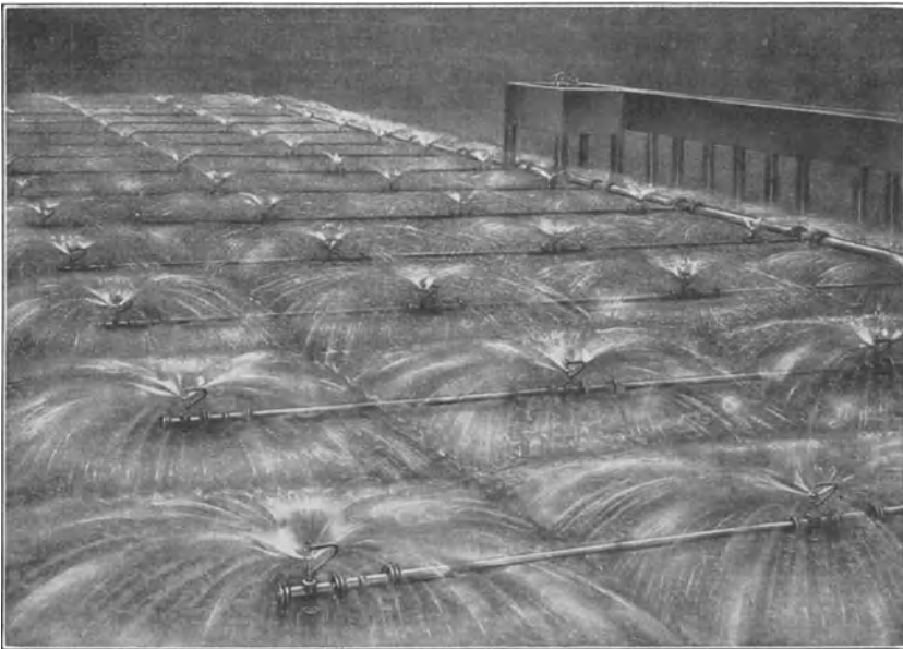
Abb. 277b. Streudüsen in Tätigkeit.
