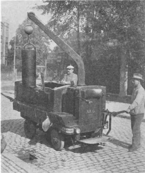
Abb. 160. Elektrokarren für Sinkkastenreinigung.
