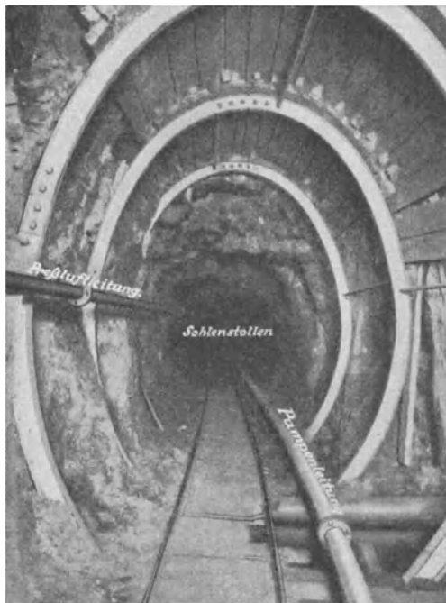
Abb. 123. Tunnelbau mit eisernen Ringen 1 .
