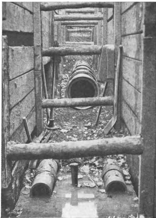
Abb. 116. Baugrubentwässerung mittels Drainage (nach Hahn und Langbein).
