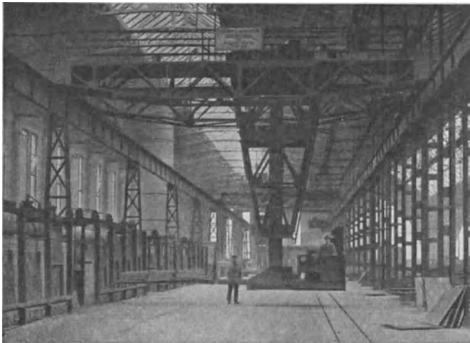
Abb. 57. Pratzenkran beim Laden der Glühöfen (links) und Absetzen auf Kühlpritschen (rechts).
