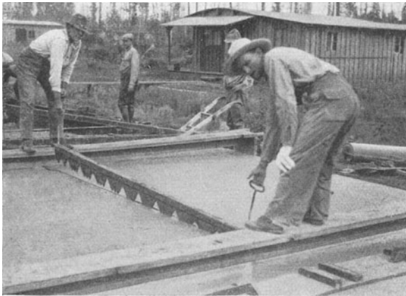
Abb. 123. Fugenblock aus Stahl mit Aussparungen.
