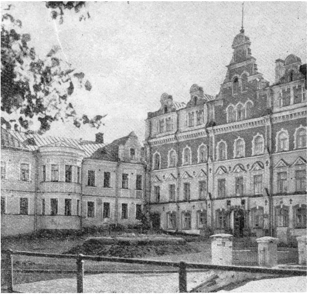
Здание бывшей ратуши (справа).
