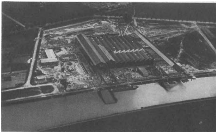
Abb. 75. Die Deutschen Asbestzementwerke Berlin-Rudow während des Baues.
