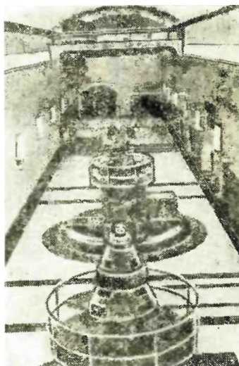
рис. 4.10. Освещение машинного зала гидроэлектростанции Ханлэк II отраженным светом в сочетании с настенными светильниками с люминесцентными лампами.
