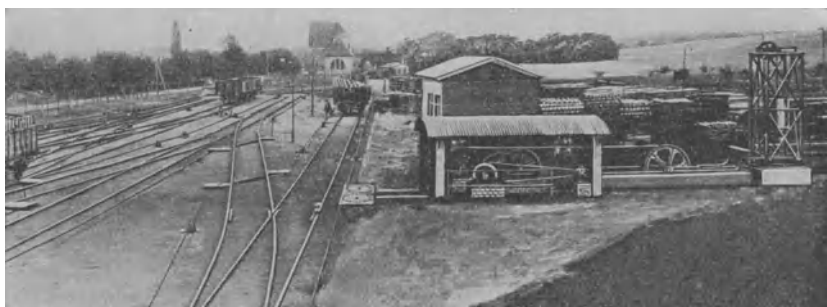
Fig. 127. Verschiebeanlage mit endlosem Seil auf einem Werkbahnhof. Rechts Antrieb mit selbsttätiger Seilspanvorrichtung.
