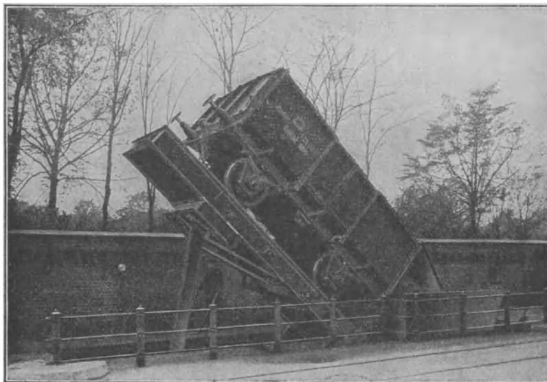
Fig. 119. Eisenbahnwagen-Kipper.
