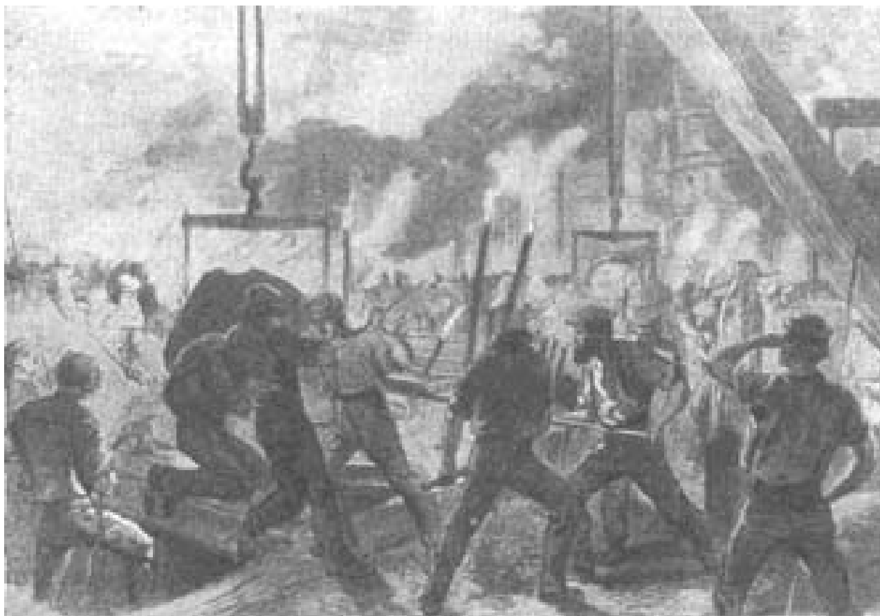
Отливка больших цилиндров на заводе Джексона и Уоткинса в Лондоне. Гравюра 1863 г.
