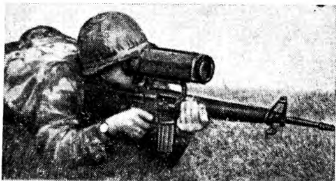
Рис. 78. Тепловизионный прицел SPTS фирмы «Магнавокс» на 5,56-мм винтовке M16, действующий в диапазоне 3—5 мкм
