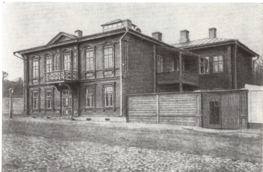
Дом на Канатной улице в Нижнем Новгороде. Здесь в 1900—1901 годах жил А. М. Горький.
