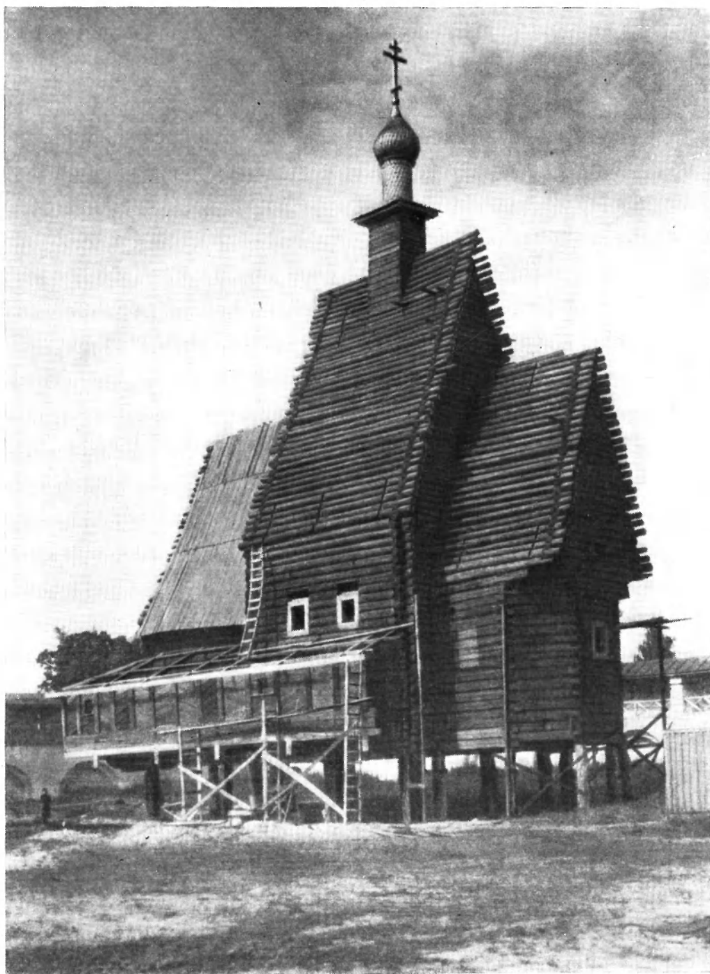
Рис. 13. Общий вид Спасо-Преображенской церкви в процессе сборки
