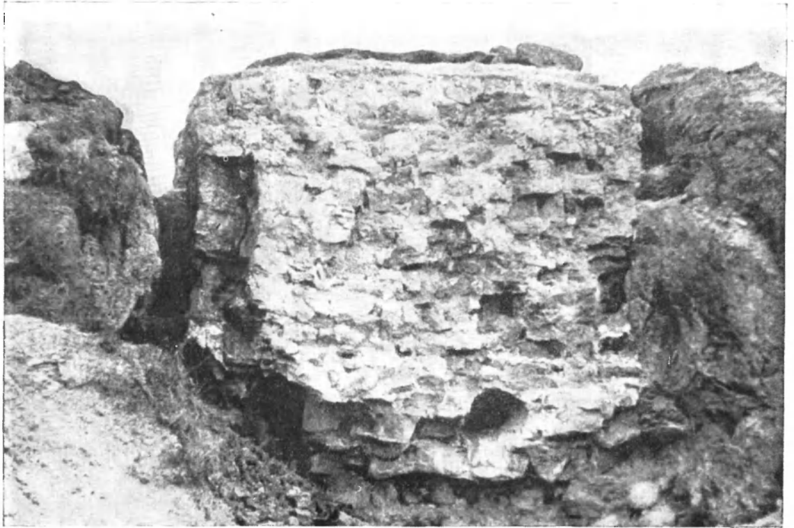
Рис. 5. Торец пилон ворот вала Новгородского острога
