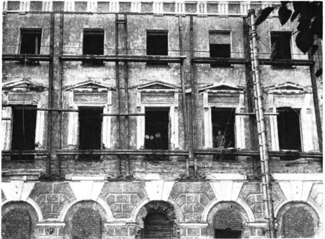
Рис. 3. Металлическая рама, поставленная на главный фасад здания бывшего Павловских казарм
