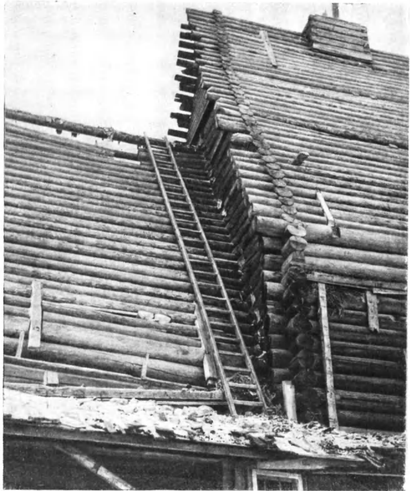
Рис. 5. Кровля молельни Спасо-Преображенской церкви в процессе разборки
