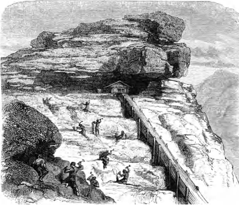
Fig. 82 Arbeiten am Hammerberge.
