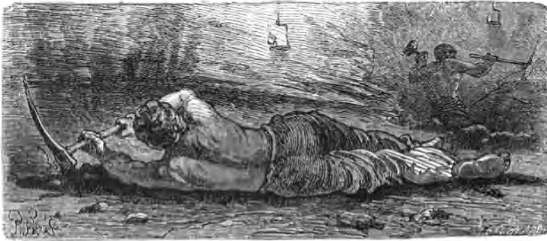
Fig. 102. Arbeiten in den Krummhalsstrecken.
