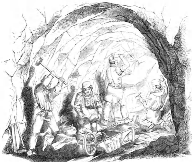
Fig. 47. Arbeiten vor Ort. Nach Heuchler's Werk „Die Bergknappen“.
