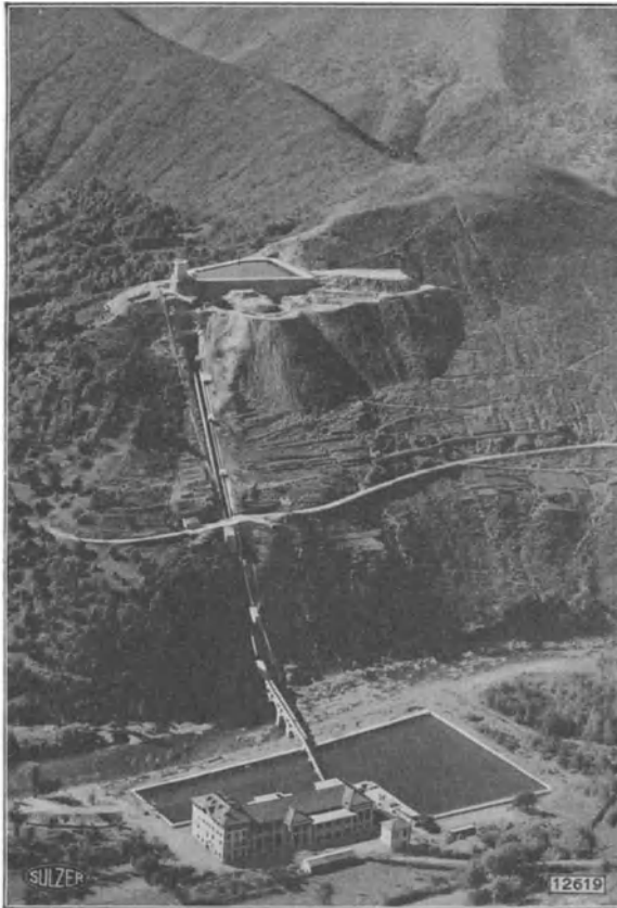
Abb. 347. Gesamtansicht der Kraftspeicheranlage Funghera. Leistung 4000 PS.
