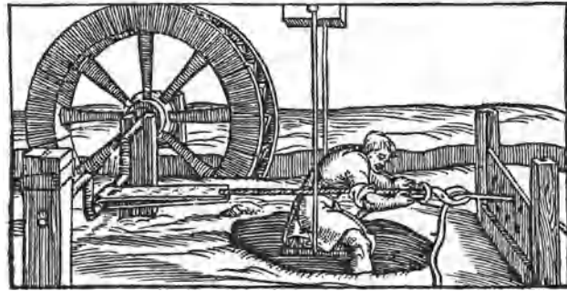
Abb. 34. Eisendrahtzug Biringuccios.
