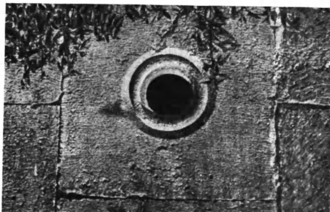
Рис. 4. Окно южного фасада жаматуна Санаина. На поверхности камня видны следы от инструмента
