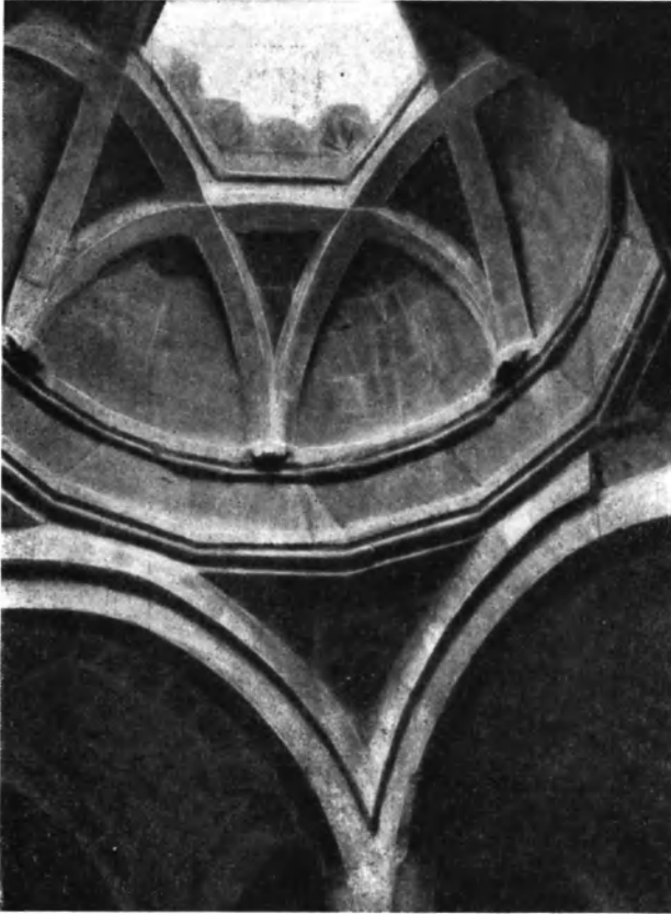
Рис. 42. Перекрытие купола жаматуна Хоранашата
