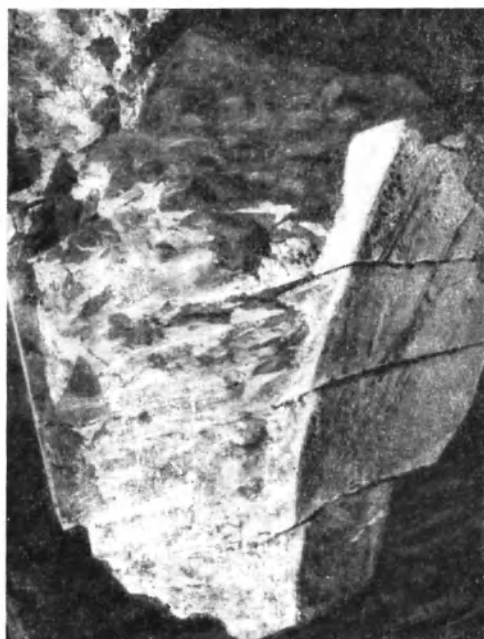
Рис. 35. Фрагмент разрушенного купола Ованнаванка. Видна наклонная форма граней камней
