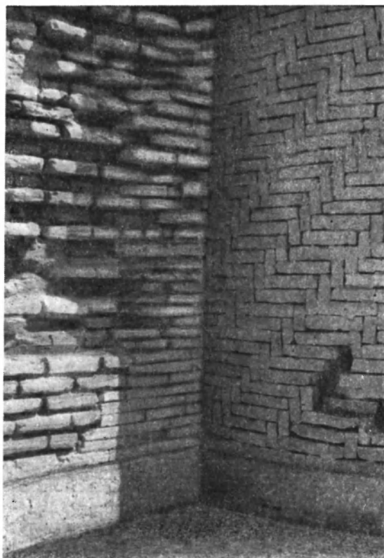
Рис. 24. Деталь кладки пилона портала
