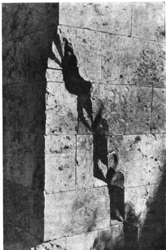
Рис. 26. Агарцин. Деталь юго-восточного угла трапезной
