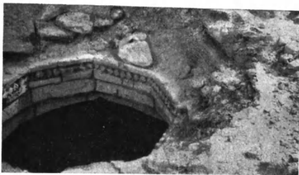
Рис. 9. Световое отверстие в крыше
