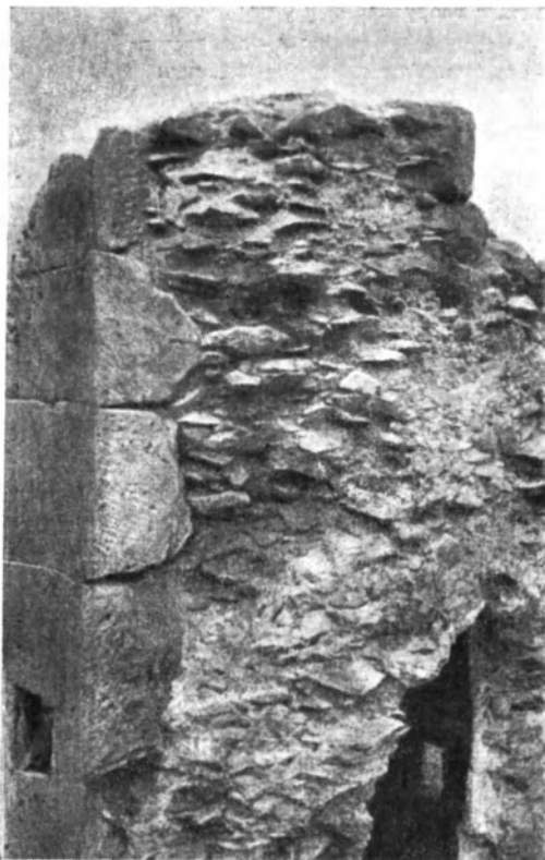
Рис. 13. Расположение щебенки в бетоне церкви Аюга
