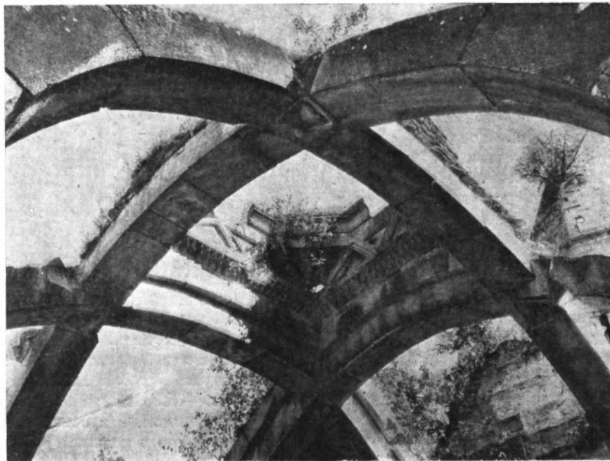
Рис. 38. Перекрещивающиеся арки перекрытия жаматуна Хоракерта
