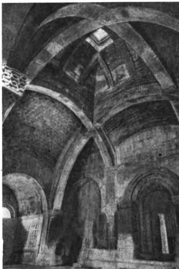
Рис. 41. Перекрещивающиеся арки перекрытия интерьера большого жаматуна Ахпата
