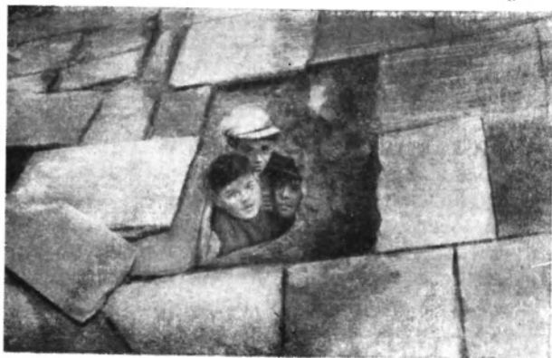
Рис. 56. Подростки в кувшине-карасе, замурованном в перекрытии жаматуна Санаина
