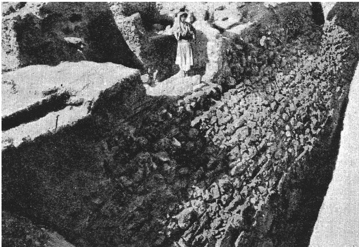
Рис. 36. Кладка стен Иерихона.
