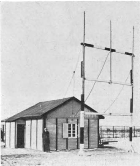
Abb. 134. Lorenz-Ultrakurzwellenfunkbake für Schlechtwetterlandung.
