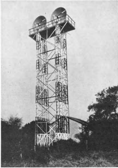
Abb. 102. Sende- und Empfangsspiegel des Mikrostrahlensystems Calais—Dover.
