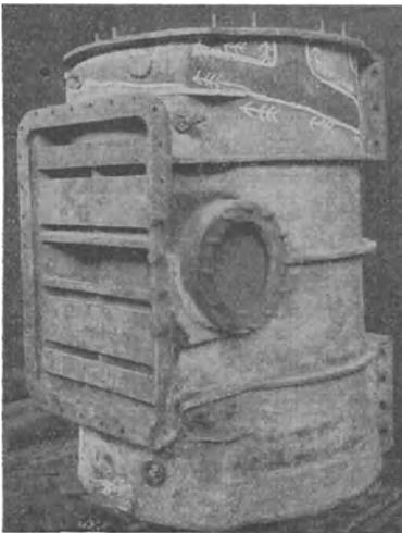
Abb. 54. Gasschweißungen an einem Dampfzylinder.
