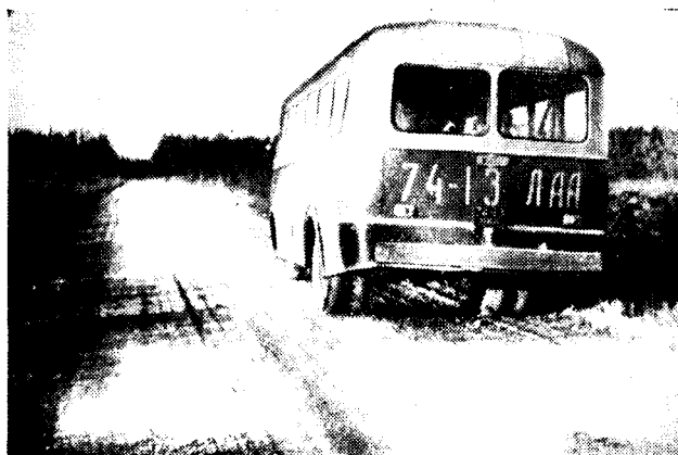
Рис. 4. Автодорога на болоте с глубоким торфом на хворостяном настиле после четырехлетней эксплуатации (Сецесское лесничество Екабпилского леспромхоза Латвийской ССР).
