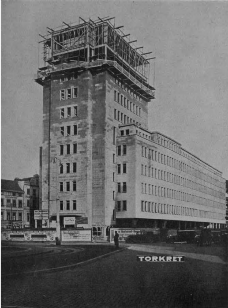
Abb. 88. Anwendung des Torkret Schnellgerüsts: Haus Grenzacht, Aachen.
