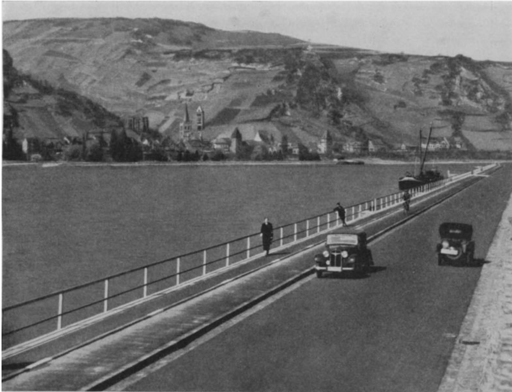
Abb. 26. Reichsstraße Nr. 42: Wiesbaden—Bonn 1 ; Strecke gegenüber von Bacharach am Rhein. Breitenmaße: Gehweg 1,40, Radfahrweg 1,90 — gepflasterte Halbrinne 0,50 — Fahrbahn 6,00 — gepflasterte Vollrinne 0,70; sodann Stützmauer der rechtsrheinischen Eisenbahn.
