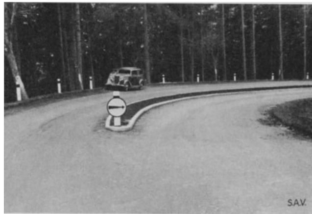
Abb. 22. Fahrbauteilung auf der Straße Neustadt—Donaueschingen zur Sicherung der genauen Einhaltung der vorgeschriebenen Fahrbahnseite in der Krümmung.
