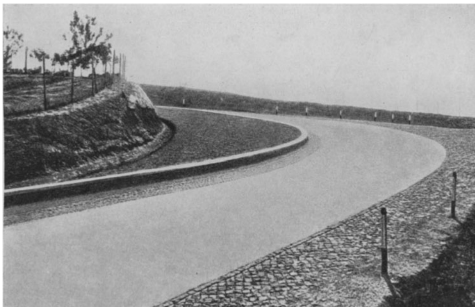
Abb. 24. Freigelegte Kurvensicht auf der Via Cassia (Rom—Florenz).
