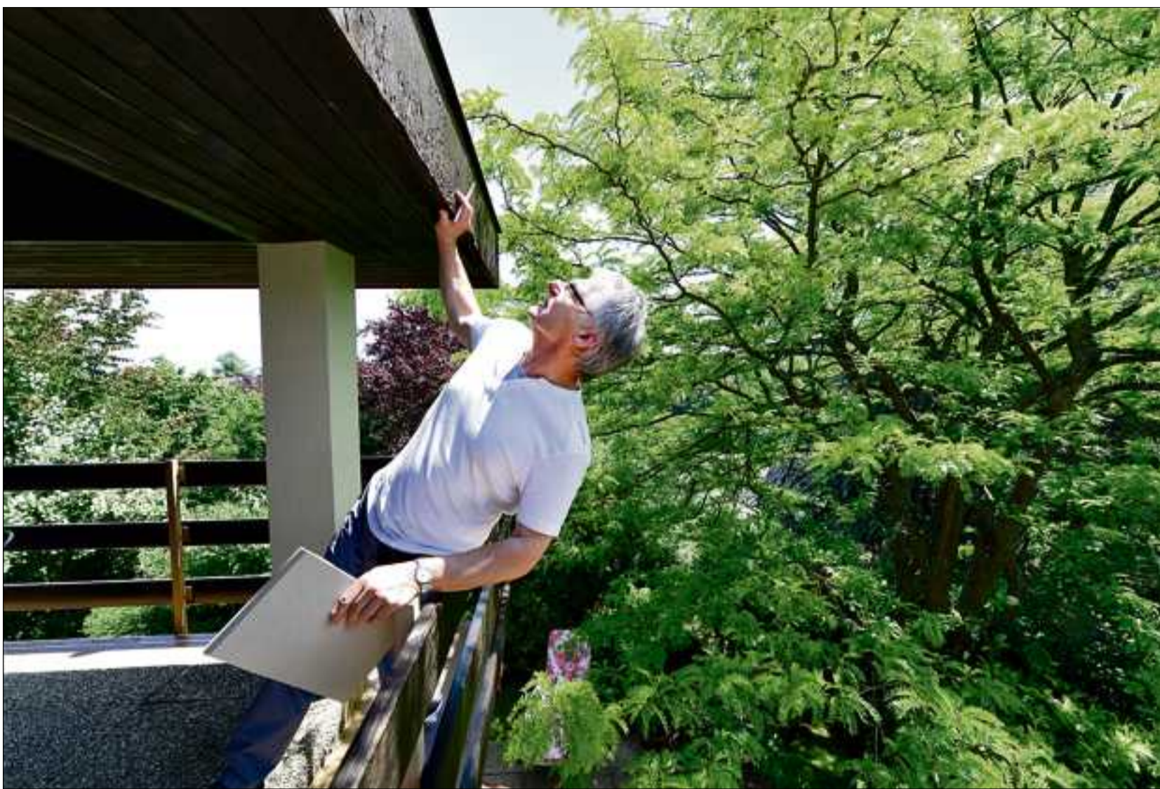
L'expert traque les «ponts de froid». «Si une dalle se prolonge vers l'extérieur, elle ramène le froid vers l'intérieur», explique Roger Lambert aux propriétaires. LULLY (VD), JUIN 2012
