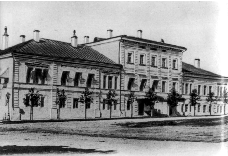
Здание симбирской удельной конторы. 1890-е гг.
