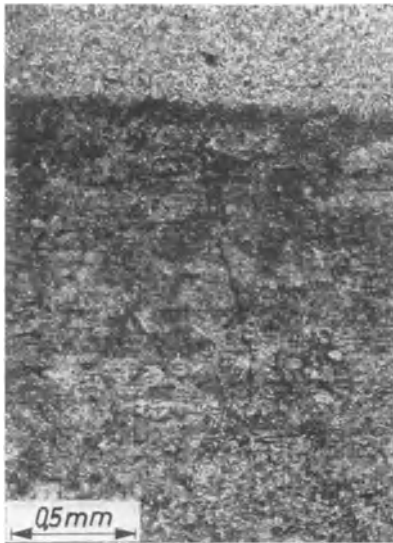
Abb. 51. Riß in der Halsnaht der Zugzone des Trägers 2, bei a in Abb. 50.
