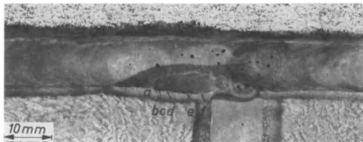
Abb. 90. Abschnitt 5 (Längsschnitt) aus der Halsnaht der Druckzone des Trägers 9. Zustand, nachdem seitlich (hinten) 3 mm abgehobelt waren. In der Übergangszone zum Stegblech sind 6 Querrisse a bis f sichtbar.
