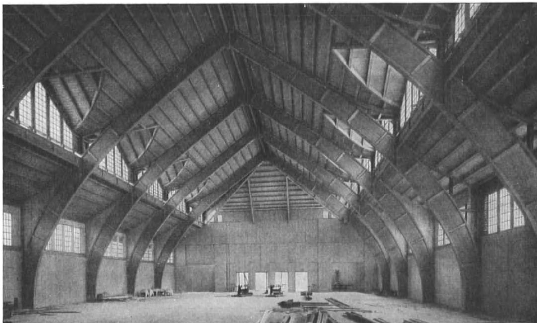
Abb. 10. Vollwandige Dreigelenkbögen mit I-Querschnitt (s. Abb. 8, 53, 56); 1913 in Leipzig errichtet, Spannweite 25 m bei 6,25 m Binderabstand und 15 m Scheitelhöhe. Zeitdauer der Aufstellung einschließlich aller Vorbereitungen 1 Woche<sup>1)</sup>.
