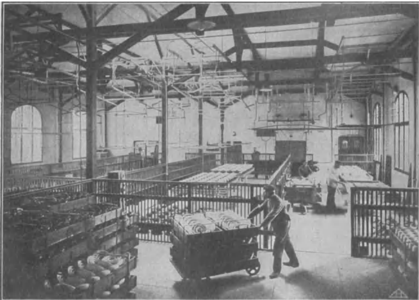
Abb. 17. Hochspannungsprüffeld für Stückprüfungen (Massenprüfung von Isolatoren).
