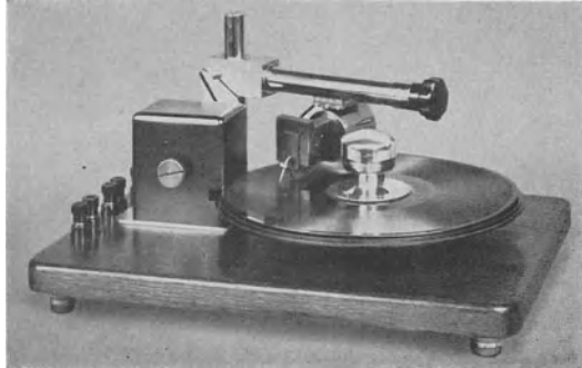
Abb. 125. Bolometrisches Abtastgerät für Schallplatten.
