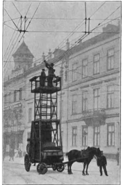
Abb. 81. Montagewagen an der Leitungsanlage in 7,0 m Höhe.
