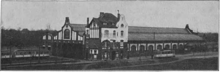
Abb. 108. Bahnhof Thielenbruch der Vorortbahn Cöln—Berg.-Gladbach.
