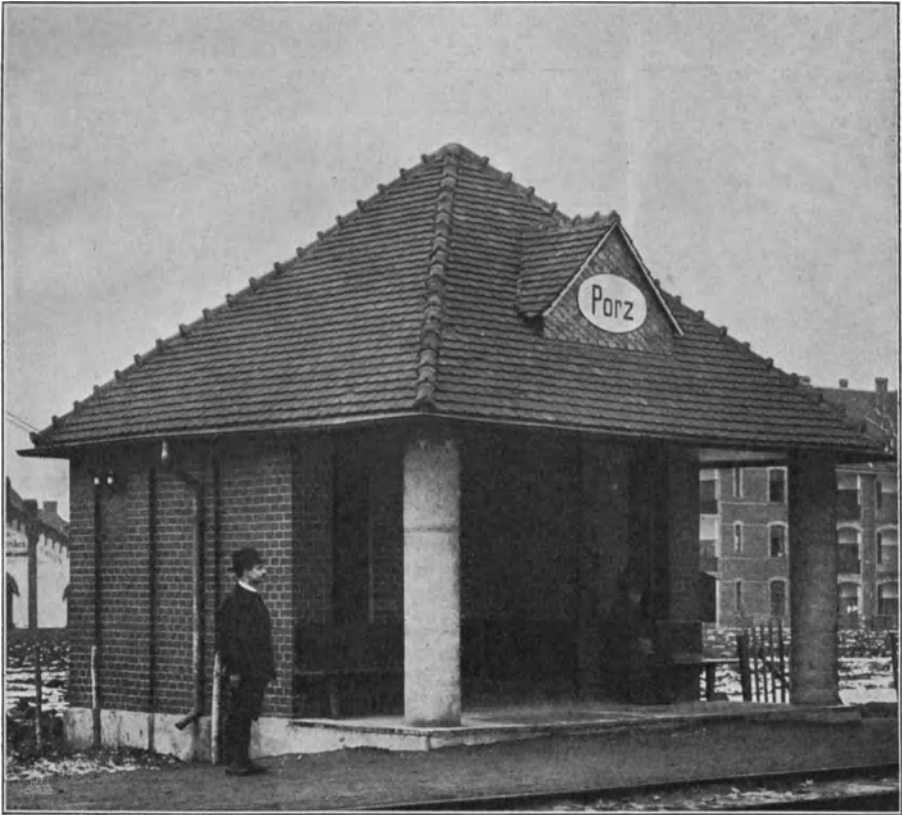
Abb. 102. Wartehalle der Vorortbahn Cöln—Porz.
