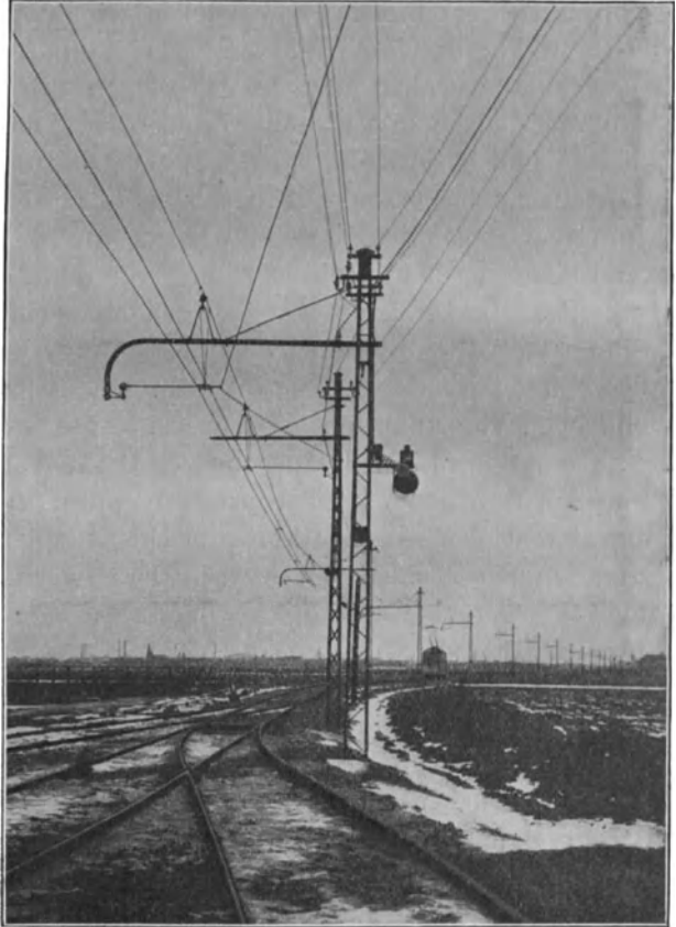
Abb. 89. Licht- und Flügel-Signal der selbsttätigen Streckensicherung.
