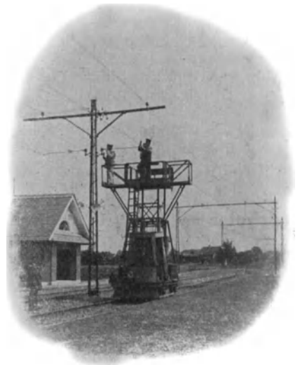
Abb. 86. Vorortbahn-Montagewagen mit elektrischem Selbstantrieb.
