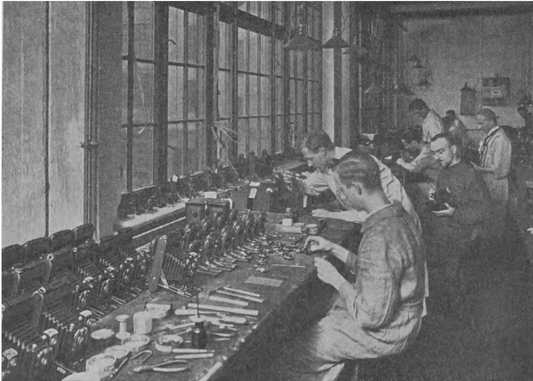
Abb. 23. Kamerabau. Einsetzen der Objektive in die Kamera.
