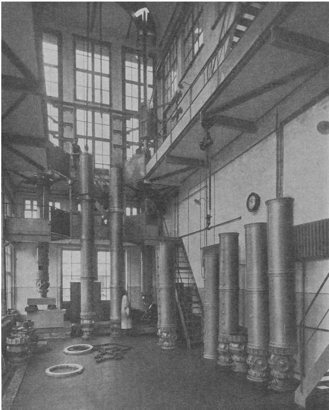
Abb. 40. Justiererei der Standsehrohre.
