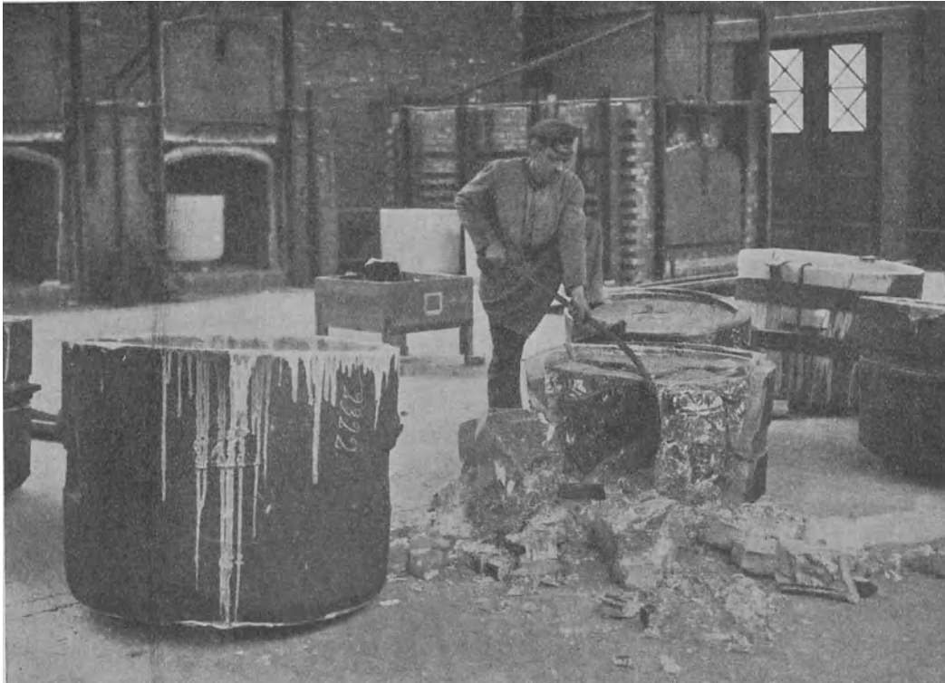
Abb. 7. Das Zerlegen des roh abgekühlten Hafens.
