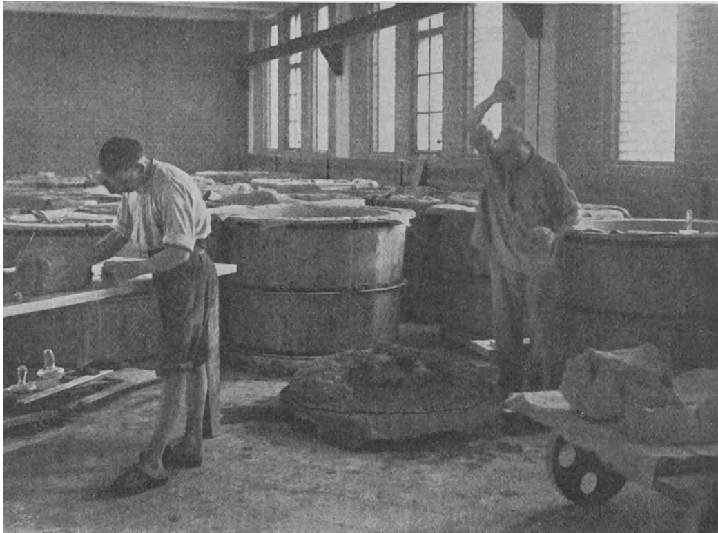
Abb. 4. Das Hafennachen von Hand. Der Ton wird durch Werfen aneinandergefügt.
