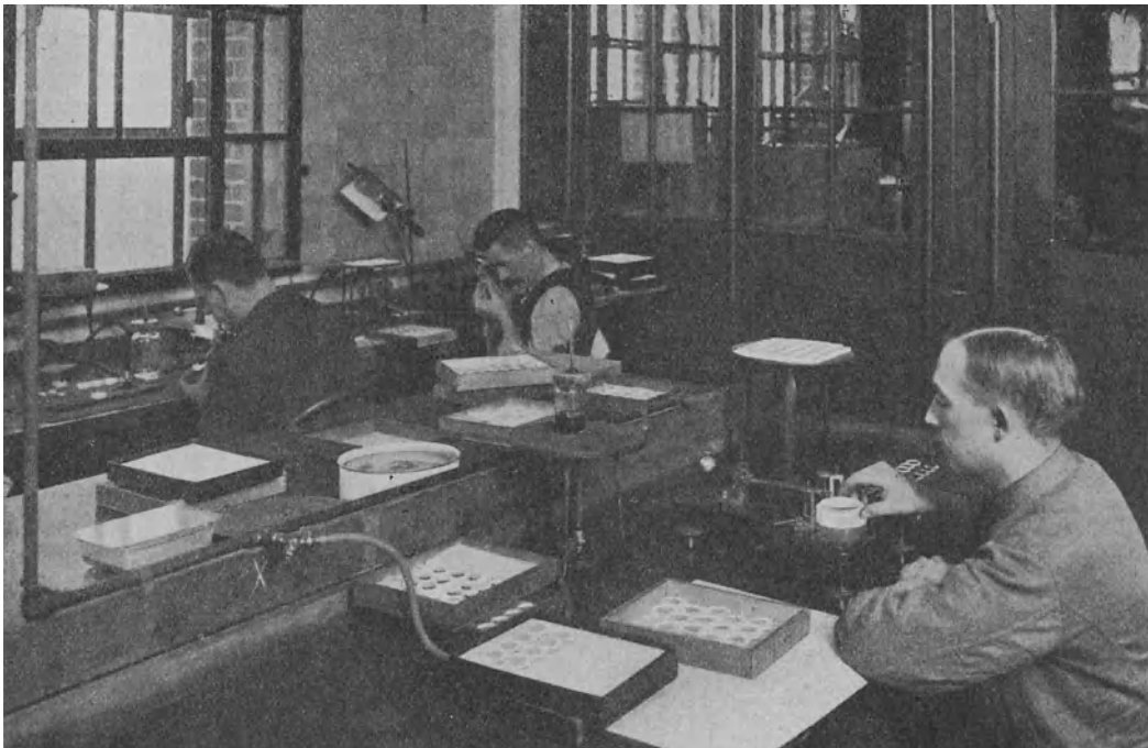
Abb. 20. Verkitten der Linsen. Unter fortwährendem Drehen der Linsen beobachtet man die Libelle, die auf dem gegen die Linsenfläche anliegenden Fühlhebel angebracht ist.
