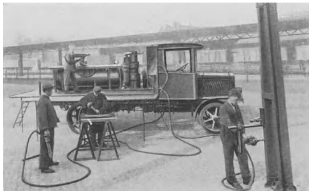
Abb. 148 Älterer fahrbarer Druckluftherzeuger mit stehendem Kompressor Bauart SS
