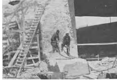
Abb. 85 Brückenabbruch mit FMA-Aufbruchhammer Tabelle 24 Nr. 1—3, 31—35
