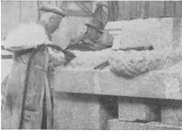
Abb. 90 Bildhauerarbeiten mit FMA-Meißelhammer Tabelle 23 Nr. 19—24
