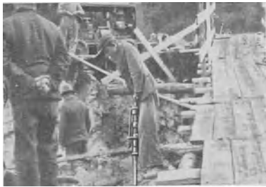
Abb. 86 Fundamentaushub m. FMA-Aufbruchhammer Tabelle 24 Nr. 1—3, 21—35
