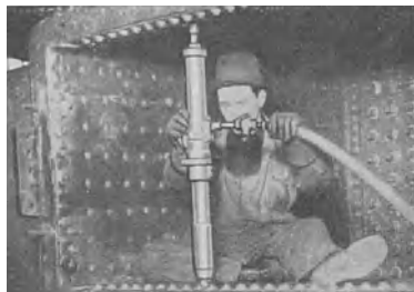
Abb. 46 Kesselnieten mit FMA-Spanten-Niethammer Tabelle 22 Nr. 41—45/51—55
