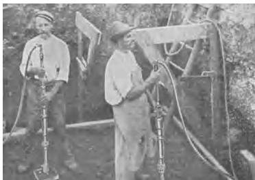
Abb. 82 Betonstampfen mit FMA-Stampfer Tabelle 24 Nr. 41—48
