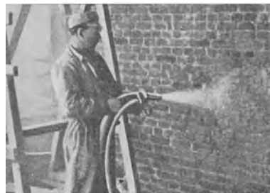
Abb. 107 Torkretverfahren Auftragen von Zement auf Mauerwerk
