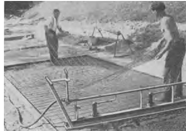
Abb. 79 Betonstampfen mit FMA-Vibrator Tabelle 24 Nr. 51—53
