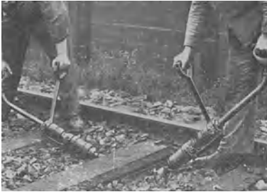
Abb. 102 Gleisstopfen
