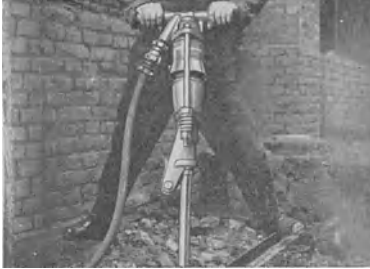
Abb. 84 Fundamentbrechen m. FMA-Aufbruchhammer Tabelle 24 Nr. 1—3, 31—35
