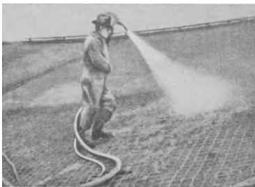
Abb. 106 Torkretverfahren Auftragen von Zement auf Flächen
