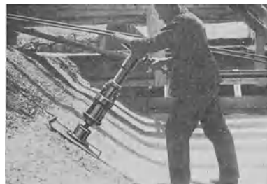
Abb. 81 Böschungstampfen mit FMA-Stampfer Tabelle 24 Nr. 4, 1—3
