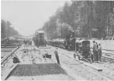
Abb. 78 Straßenbau mit fahrbarem FMA-Kompressor Seite 176
