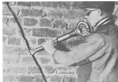
Abb. 89 Mauermeißeln mit FMA-Meißelhammer Tabelle 23 Nr. 1—24
