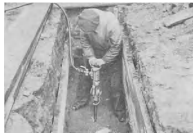
Abb. 87 Gesteinbohren mit FMA-Bohrhammer
