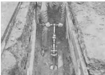
Abb. 88 Grabenaushub mit FMA-Spätenhammer Tabelle 24 Nr. 21/22
