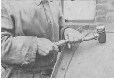
Abb. 96 Rostabklopfen mit FMA-Abklopfen Tabelle 23 Nr. 31—33
