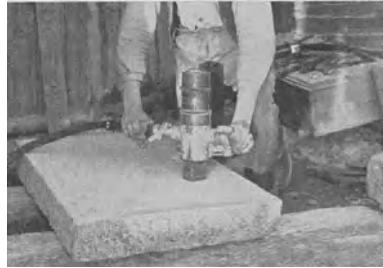
Abb. 91 Stocken mit FMA-Stockhammer
