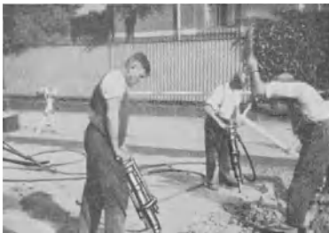
Abb. 80 Betonaufbrechen mit FMA-Aufbruchhammer Tabelle 24 Nr. 1—3
