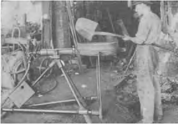
Abb. 72 Sandsieben mit FMA-Sandsiebmaschine Seite 282
