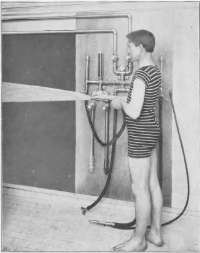
THE BROKEN HORIZONTAL JET DOUCHE.
