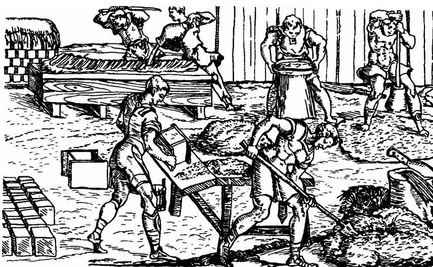
Изготовление кирпича. Эпоха Возрождения
