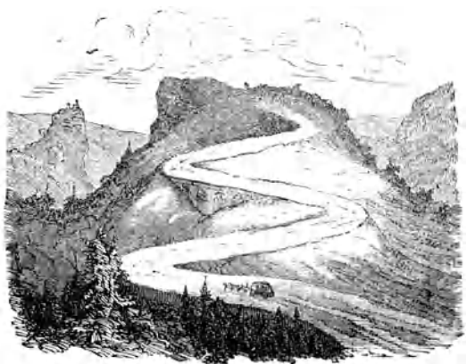
Fig. 14. Kunststraßenanlage zur Ueberwindung zu großer Steigung
