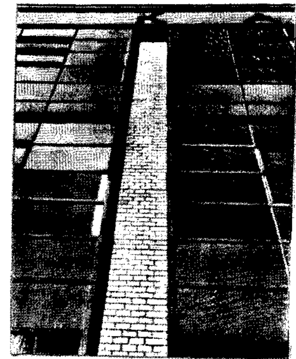
Гропиус и А. Мейер. Деталь здания фабрики «Фагус», Альфельд-на-Ляйне, 1911
