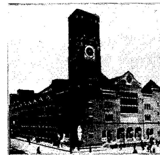
Берлаге. Здание биржи, возведенное в 1897—1903 гг.
