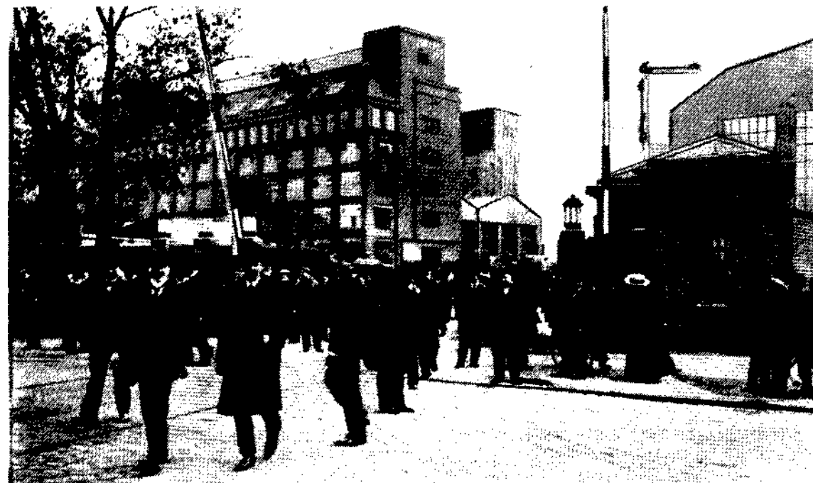
Беренс. Фабричный комплекс АЭГ в Берлине, 1912. Слева — высоковольтная станция, справа — сборочный цех
