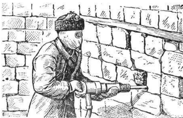
Рис. 36. Пробивание отверстия в стене убежища
