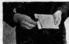
Рис. 10. Отделение отрезанной части плитки
