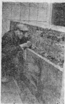
Рис. 3. Облицовка цоколя одного из помещений гостиницы «Россия» (Москва) плитами из известняка
