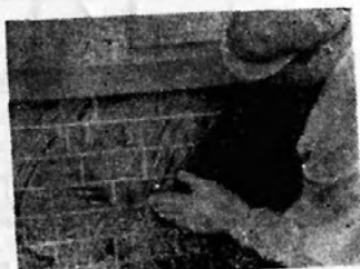
Рис. 19. Заполнение швов между плитками типа «кабанчик»
