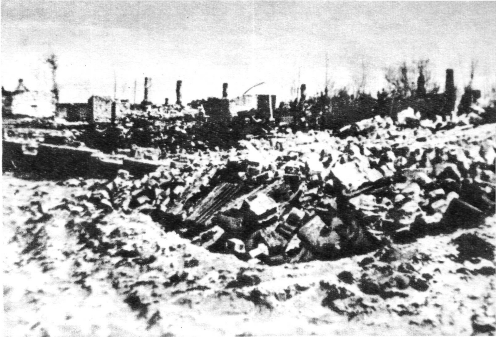
Развалины жилых домов по ул. Пушкина. в гор. Бобруйске.
