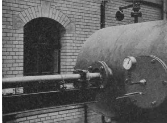
Abb. 3. Kessel mit elastischer Flanschverbindung, Widerlager und Justierlager.
