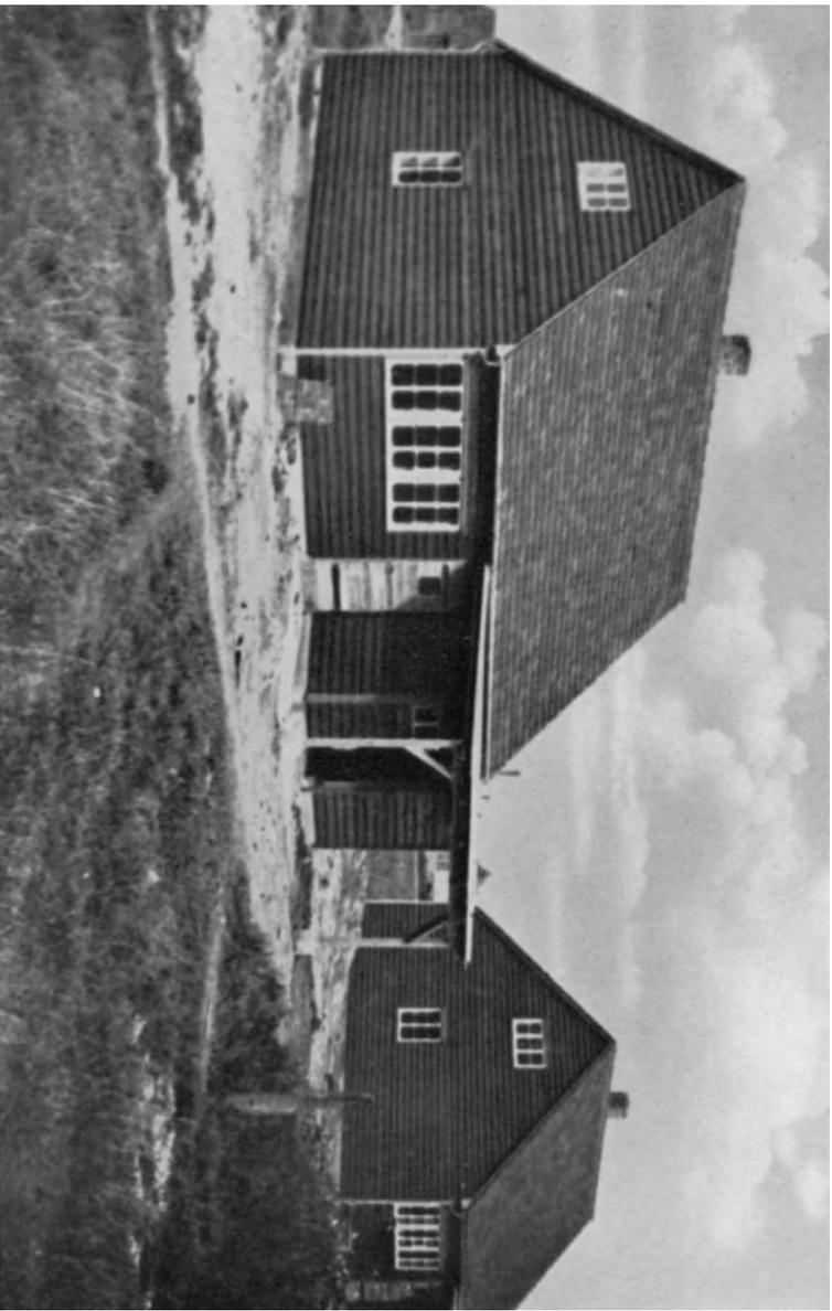
Abb. 7. Reichskleinsiedlung Karlruhe; Übernahme ortsüblicher Baumaterialien und Bauweisen. (100 Siedlerstellen; Regelfachwerkbauten mit Lehmauswicklung, außen Stülpschalung, innen gehobelte Holzverschalung mit Leistendeckung, gute Grundrißausbildung.)
