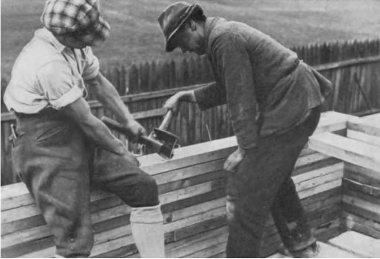
Abb. 32. Selbsthilfesiedlungsbau Kleinmünchen-Linz: Nagelung der Pfostenlage der Bohlenwände „auf Katzensprung“
