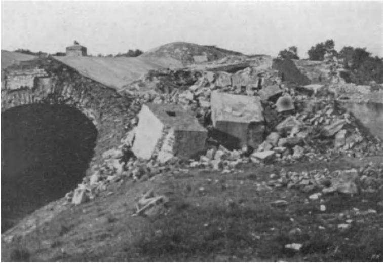
Abb. 8. Fort Biehler bei Mainz; von den Besatzungstruppen vor ihrem Abzuge gesprengt, jetzt Materialfundgrube für Siedler. (Sämtliche Baustoffe — mit Ausnahme von Kalk, Dachziegeln, Schalbrettern und Dachlatten — werden aus dem Abbrüche der alten Festungswerke gewonnen.)
