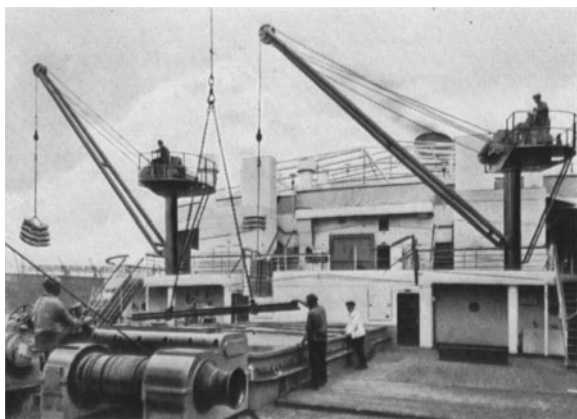
Abb. 335. Ein Bordwippkran auf Dampfer „Potsdam“ des Norddeutschen Loyd.
