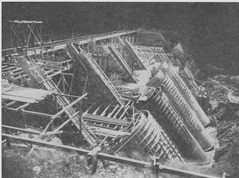
Abb. 454. Eisenbetontalsperre in Vöhrenbach (bad. Schwarzwald). Ansicht von der linken Talseite während des Baues.
