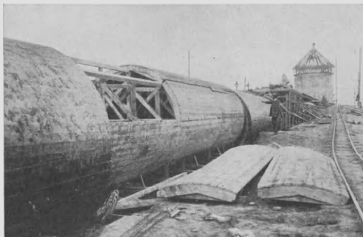
Abb. 484. Schalung des Eisenbetondruckrohres des Radaunewerkes bei Danzig.
