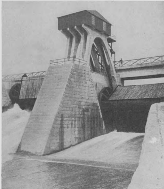
Abb. 415. Walzenwehrranlage Torshnofudforsen (Norw.). L. W. 17, H. 3,75, 6,25 u. 8,85 m.
