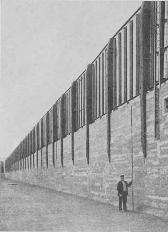
Abb. 557. Kammerwände der Hemelinger Schleuse. Bremen. Betonverkleidete Spundwände.
