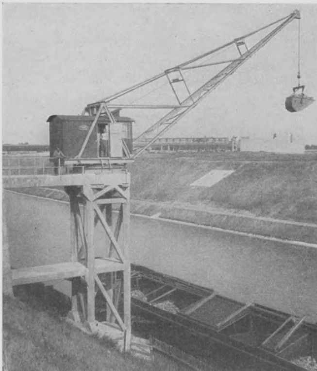
Abb. 822. Krananlage mit Unterbau in Eisenbeton.
