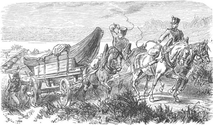
Abbrechen der Pontonbrücke.
