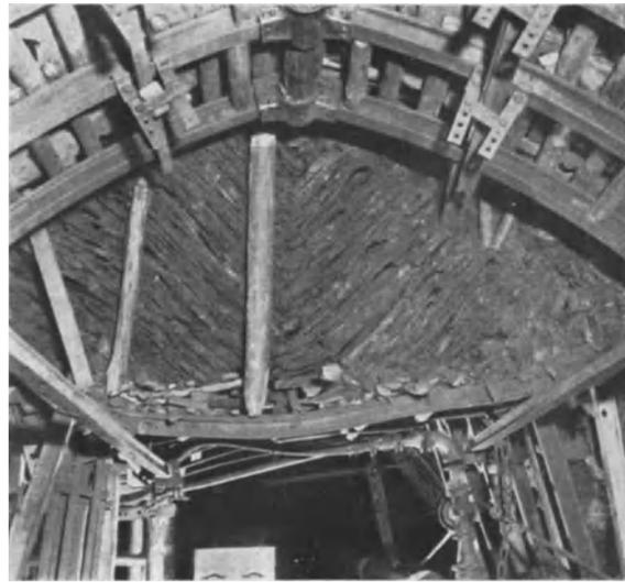
Abb. 102 Wirkung des Abbaues des Flözes Albert auf sölhlig gelagerte Schiefertonschichten im Hangenden. Zeche Dahlbusch I/VIII. Aufn. STAUBACH.
