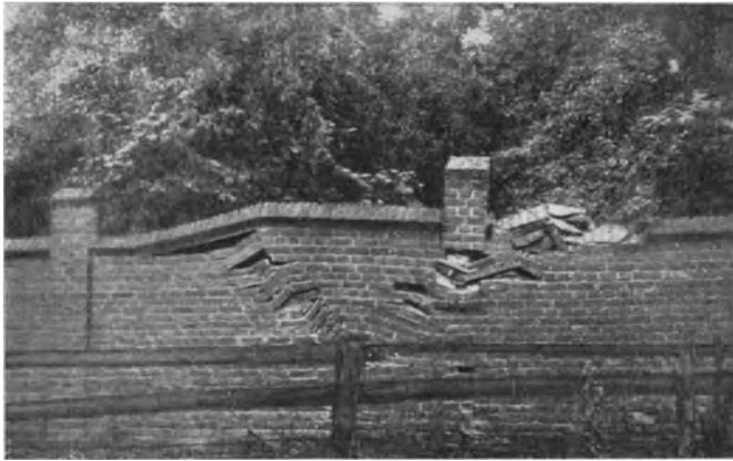
Abb. 360. Durch bergbauliche Einwirkung unter waagrechten Druck geratene Mauer. Nach SCHWARZ.
