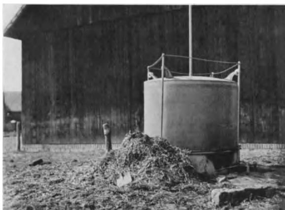
Abb. 666. Gasometer in Wessel bei Herbern. Aufn. KUKUK.
