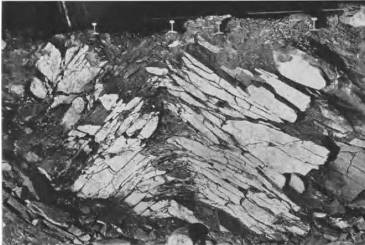
Abb. 103. Sattelförmige Aufwölbung von Sandschieferschichten in einem Querschlag als Folge des Abbaues des unterhalb gelegenen Flözes Ida. Zeche Dahlbusch I/VIII. Aufn. STAUBACH.
