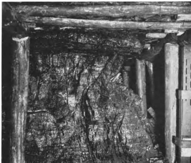
Abb. 259. Drucklagenbildung im Flöz 2 der Zeche Gneisenau. Aufn. Bergbau-Verein Essen.
