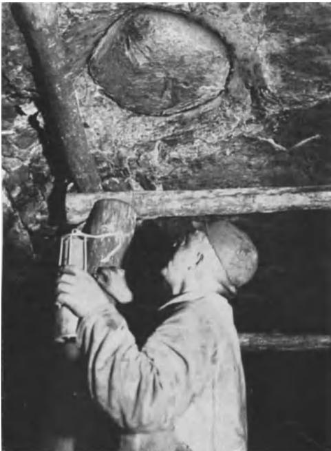
Abb. 212. Ausgeschlagener Baumstumpf (Kessel). Zeche Kurl. Aufn. GRÄFF.
