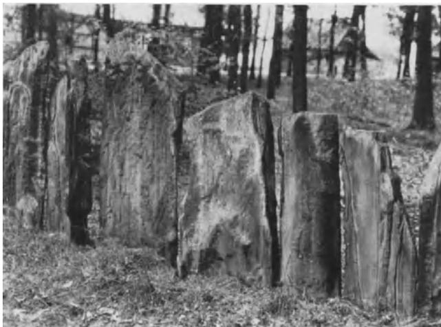
Abb. 523. Eisensandsteinzaun eines Gehöftes in Westrup bei Haltern. Aufn. OBERKIRCH.
