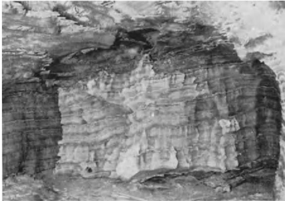
Abb. 656. Stoß eines Spülortbetriebes im weißen Steinsalz auf der 795 m-Sohle der Deutschen Solvay-Werke A.G., Borth. Aufn. des Werkes. Aus KUKUK: Bergbau 1936.
