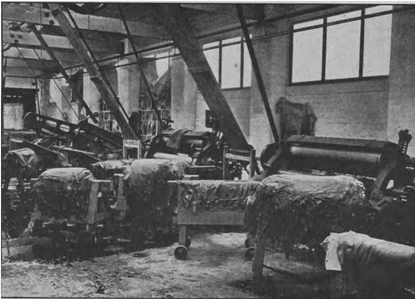
Abb. 38. Walzen-Ausreckmaschinen.
