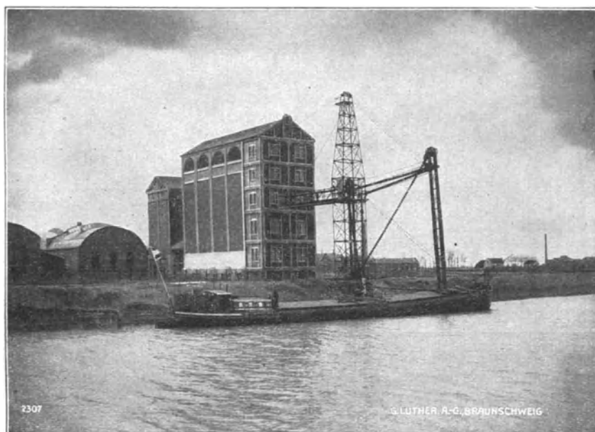
Abb. 1. Ölsaatspeicher mit mechanischem Schiffselevator und anschließender Bandbrücke.
