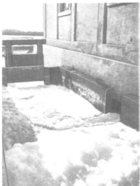
Der Lebensnerv des ganzen Salzwerkes ist die Zuleitung des Salzwassers vom Meere her; ein Pumpwerk verteilt das Wasser in die höheren Teiche. Von dem hier im Bilde gezeigten Kanal aus werden sämtliche Teiche gefüllt
