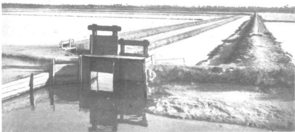
Salzgewinnung aus Meerwasser in der italienischen Kolonie Tripolis Ein Labyrinth von Schleusen und Kanälen zieht sich durch die Salzlager zu den neuen Teich- parzellen hin
