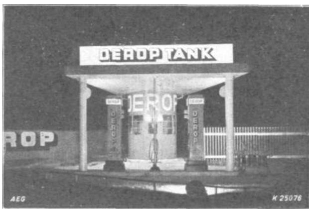
Anleuchtung der ganzen Tankstellenanlage durch zwei Flutlichtgeräte.
