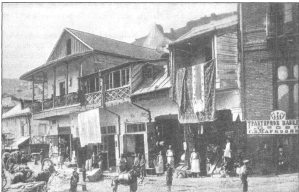
Basarstraße im Meidanviertel.
