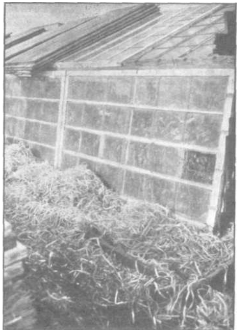
Hobelspäne zum Dichten der Fugen am Glaskasten.
