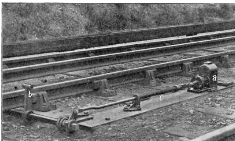
Abb. 9. Elektropneumatisch angetriebene Fahrsperr der Londoner Distriktbahn Westinghouse Bremsen-Gesellschaft, London.)
