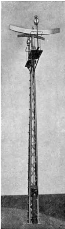
Abb. 17. Roudolfs dreistelliges Hauptsignal mit Rücklicht. Tages- und Nachtanzeige gleich. (Am Fuße des Mastes eine Acetylenflasche für die Signalbeleuchtung.)
