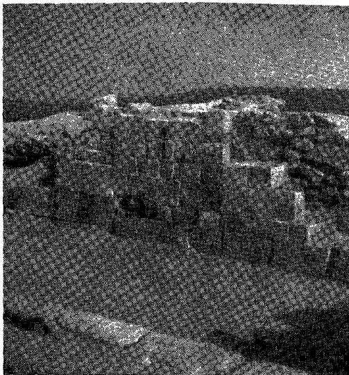
Рис. 18. Баклинское городище. Кладка 4. Строительный шов отделяет часть ее в технике „квадровой кладки“
